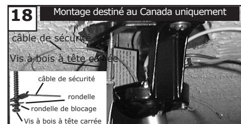
Pour le montage destiné au Canada, que ce soit selon la méthode de suspension encastrée ou selon la méthode de la tige verticale, le câble de sécurité doit être installé dans les poutres de la charpente du bâtiment à l'aide des rondelle, rondelle de blocage, vis à bois à tête carrée de 3,81 cm fournies à cet effet. Assurez-vous que lorsque le câble de sécurité est entièrement déplié, les fils de connexion sont plus longs que le câble et qu'ils ne sont soumis à aucun effort de tension.
